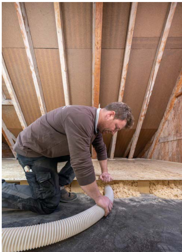
Stampio ist die holzfaserbasierte Systemlösung zur einfachen und schnellen Dämmung der obersten Geschosdecke von Bestandsgebäuden. Foto: Martin Granacher
