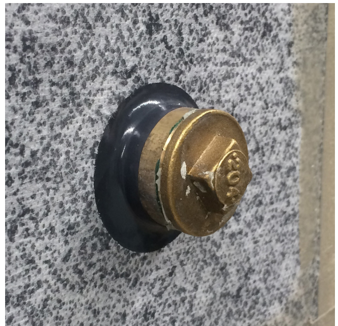
Praxisbeispiel: Rohrdurchführung mit Dichtmanschette
